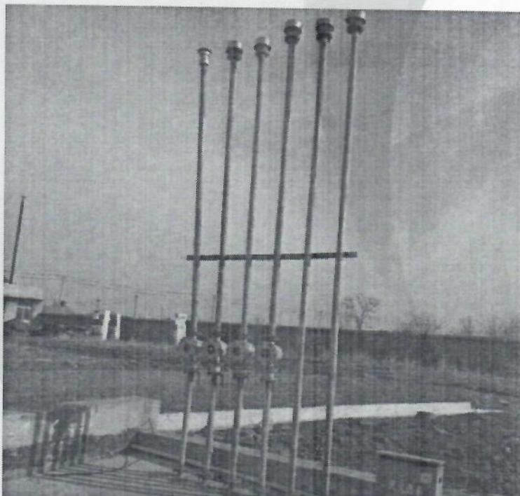
图 4-2 罐区通气管
