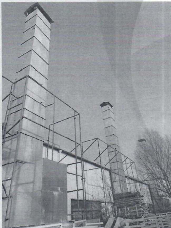
图 4-4 喷漆环节产生废气经排气筒高空排放
